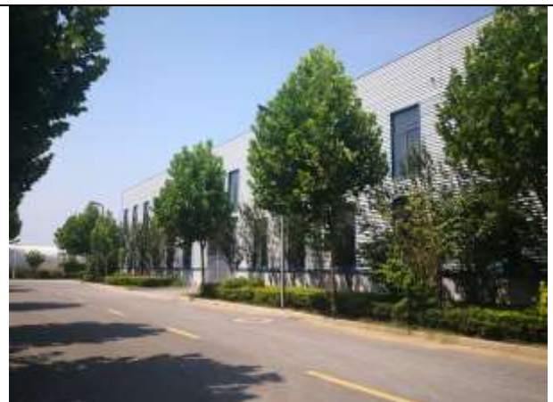
厂房外西侧园区道路
