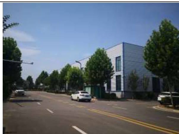
厂房外东侧园区道路
