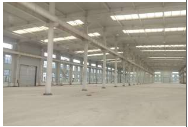
厂房内部现状
