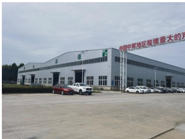
1#厂房外部照片
