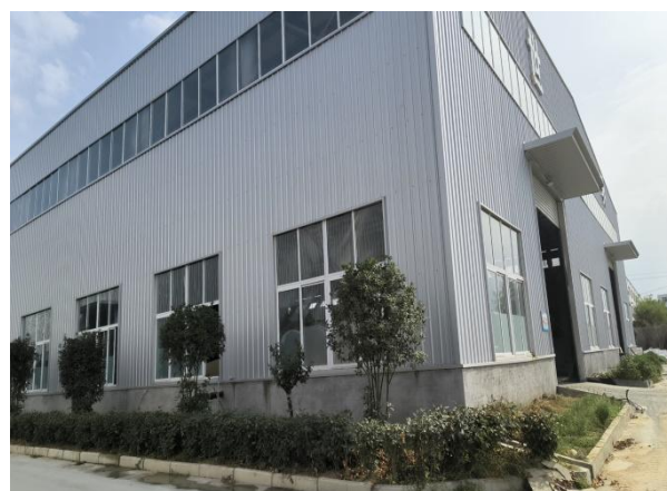
3#厂房外部照片
